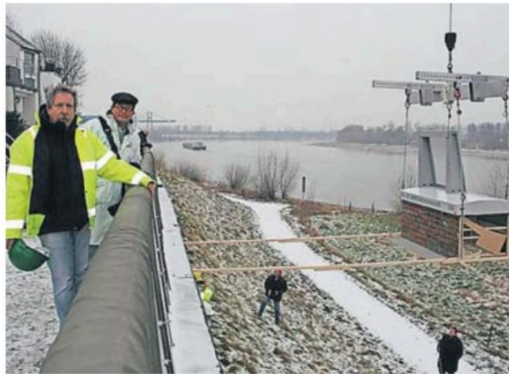
Einer der schwierigsten Abschnitte mit den höchsten technischen Anforderungen bei der geplanten Deichsanierung: das Gelände der Firma UCT im Norden von Stürzelberg.
