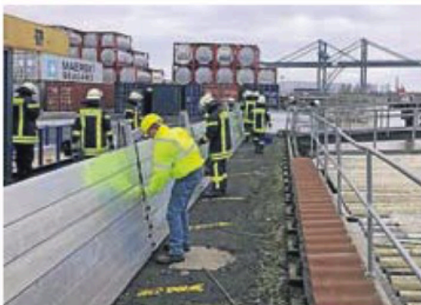
Vorsichtsmaßnahme: Gestern Morgen bauten Feuerwehrleute eine mobile Schutzwand bei UCT auf.
