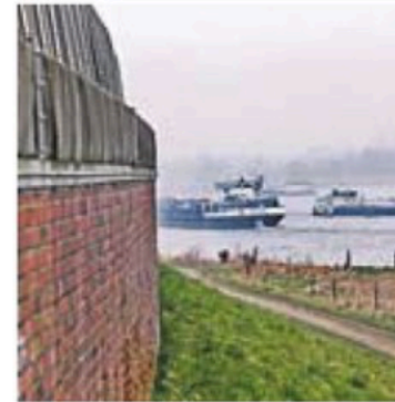
Die Sanierung des Deichs – hier in Stürzelberg – ist aufwendig. ARCHIVFOTO: ATI
