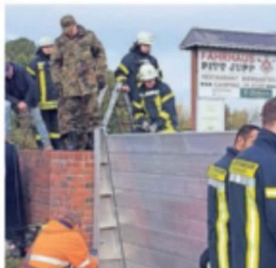
Reservisten und Feuerwehr bauen das mobile Deichtor auf.
